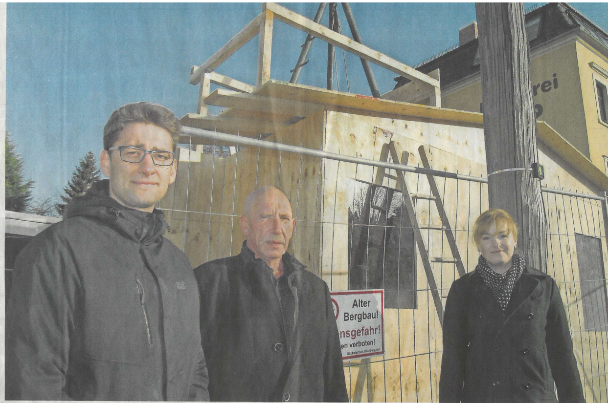
Michael Kühn vom Oberbergamt sowie Prokurist Robert Lorenz und Projektingenieurin Diana Seespeck von der Bergsicherung Freital (v. l.) betreuen ein großangelegtes Sanierungsprojekt im Altbergbau. Von einer unscheinbaren Holzhütte an der Karl-Stein-Straße in Gittersee aus geht es in die Tiefe.
