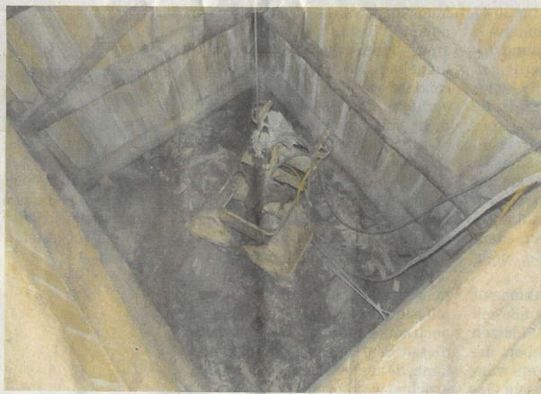
Ein alter Bohrschacht wird derzeit wieder aufgegraben und saniert.
